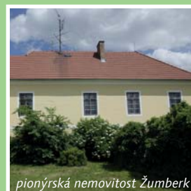
pionýrská nemovitost žumberk
